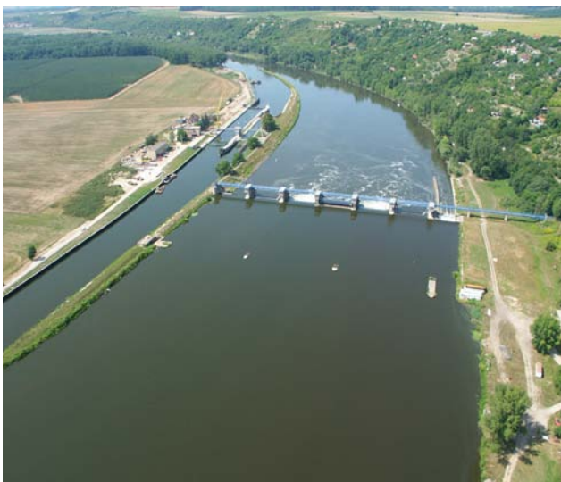
Jez na Labi u Štětí před zahájením stavby MVE Štětí.
