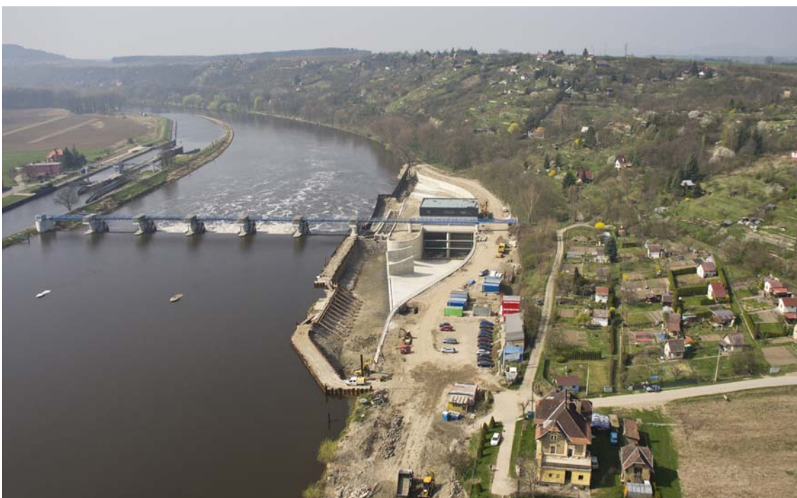
Stavba MVE Štětí – letecký snímek z března 2014
