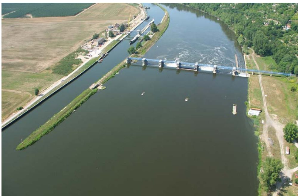
Jez na Labi u Štětí před zahájením stavby MVE Štětí.
