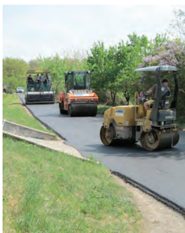
Obnova komunikace na staveništi.
