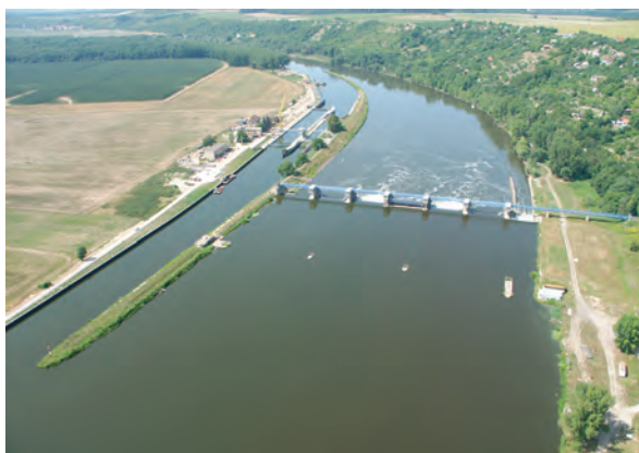
Energeticky dosud nevyužitý jez na Labi u Štětí.
