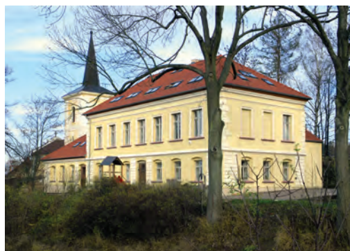
Budova respitní části komplexu dětského hospice.
