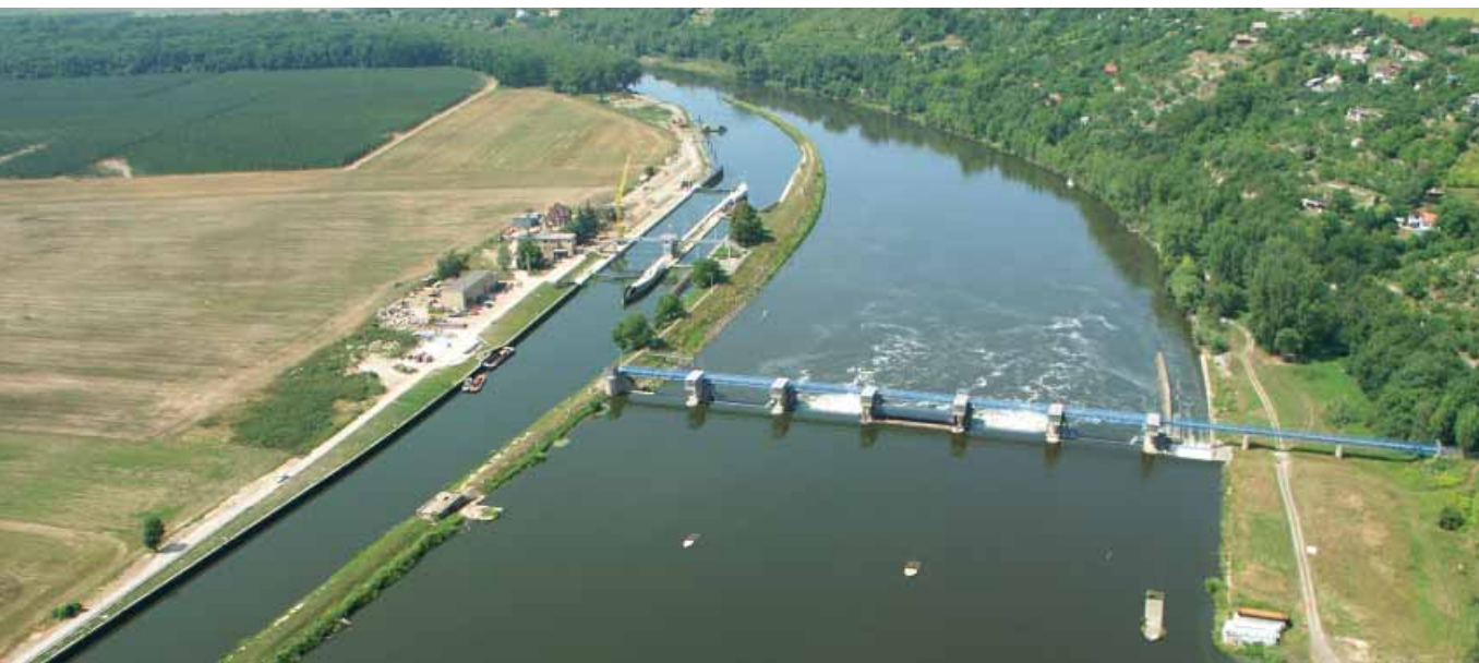
Letecký snímek jezu Štětí-Račice, na pravém břehu prostor k vybudování MVE
