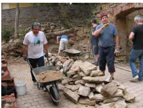
Stavba opěrné zdi
